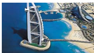
Отель-парус «Арабская башня», ОАЭ Воздухораспределительные устройства, противопожарные клапаны
