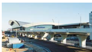
Аэропорт Внуково, г. Москва Вентиляторы дымоудаления
