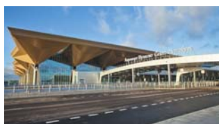
Аэропорт «Пулково», г. Санкт-Петербург Фэнкойлы
